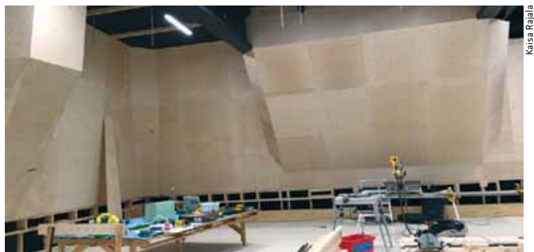
Uutta seinää tulossa.
