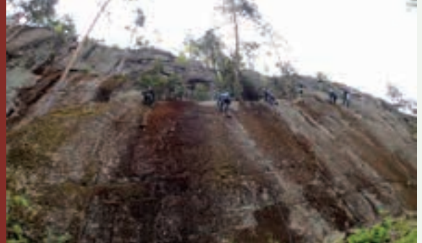
Pultin asennus on tarkkaa työtä
