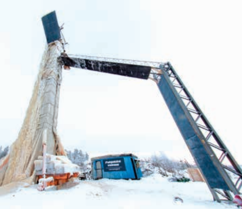
Tornia rakentamassa, Kuva: Marko Kerola
