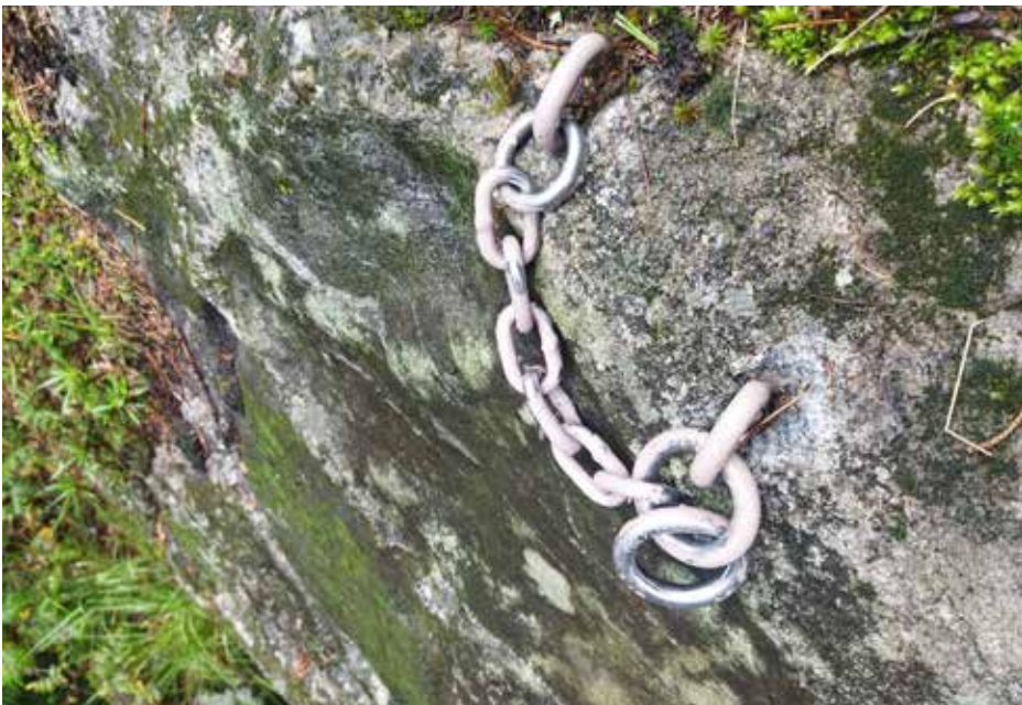
Kallioon asennettu kahdesta porahaasta ja ketjusta koostuva yläankkuri
